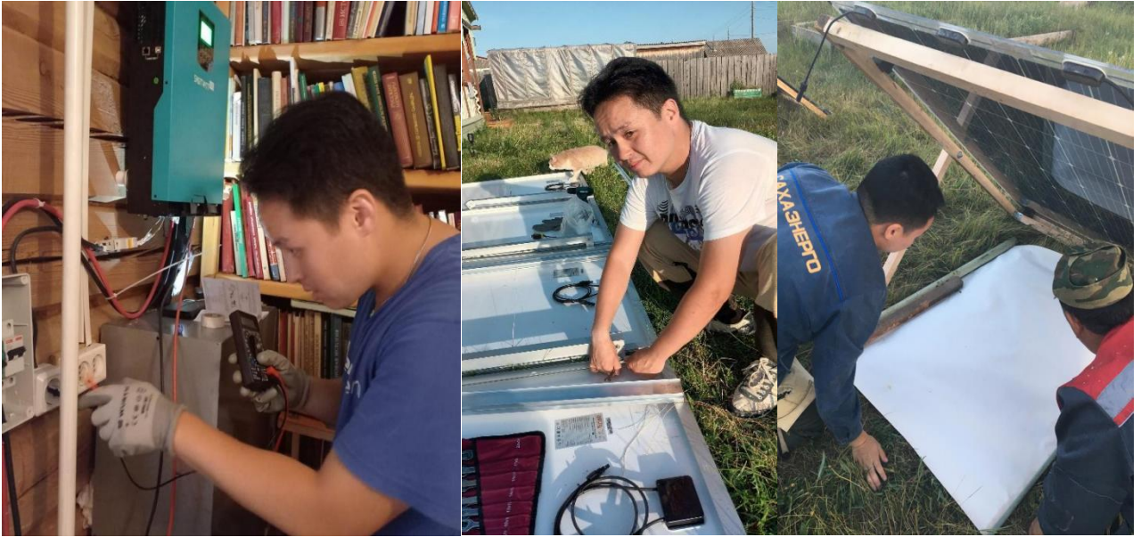
Рисунок 2.2 – Монтаж исследуемой солнечной электростанции
