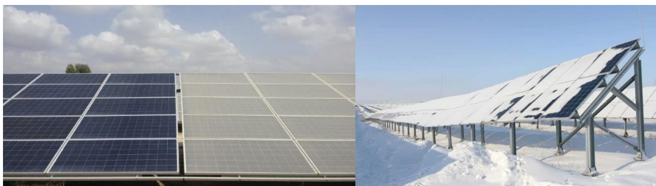
Рисунок 1.34 – Фотоэлектрические панели с поверхностным загрязнением:
